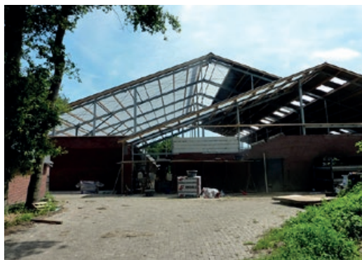
Daļa jumta nosepta ar gaismas paneļiem
